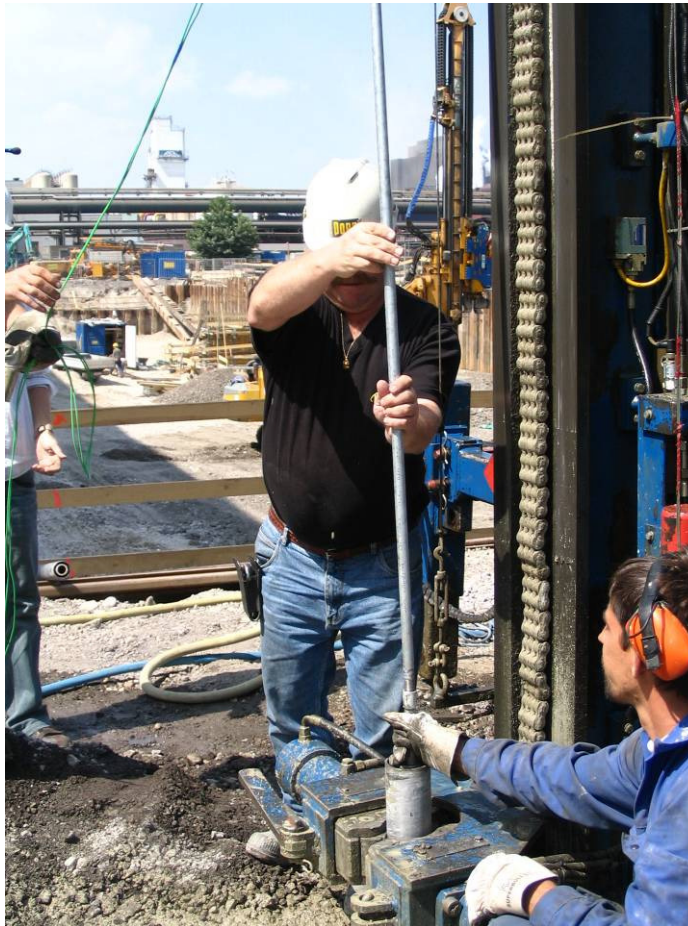
Einbau der Temperaturfühler in die DSV-Säule
